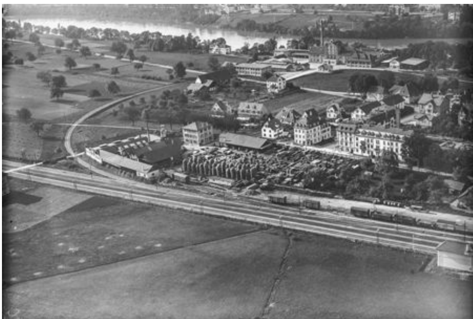
Foto 2: Ehemaliger Bahnübergang westlich der heutigen Densa-Überbauung
